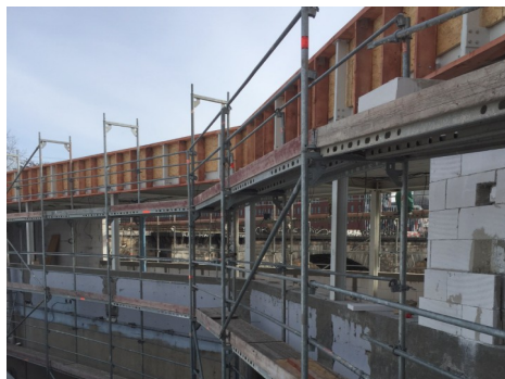
Pohled na stavbu z malého centru
